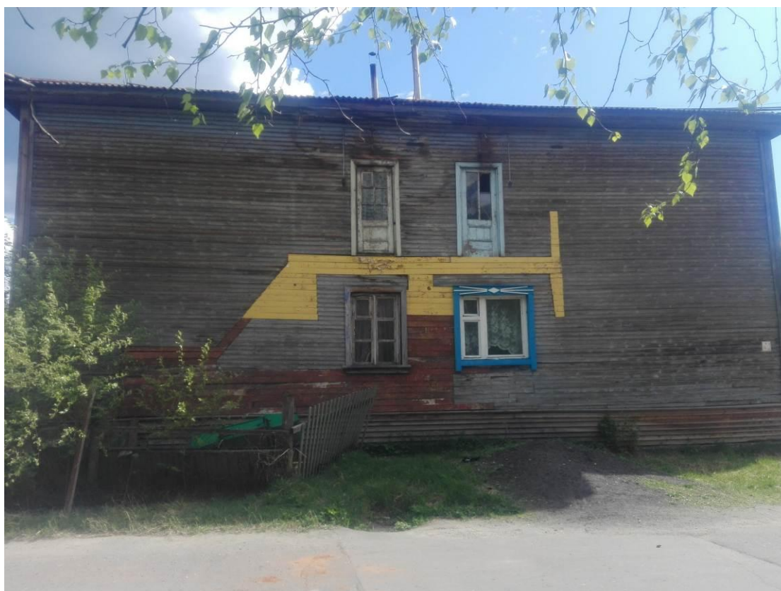
Фото В.2 – Дворовый фасад
